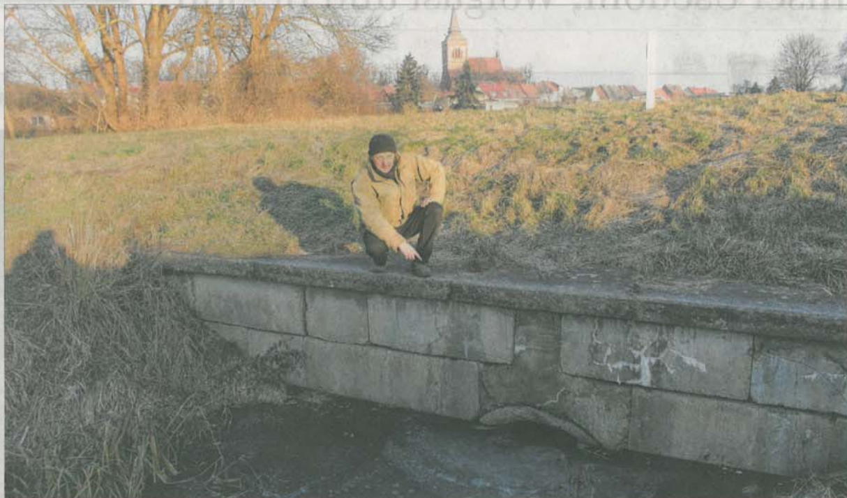
Fred Gransow am Lassaner Mühlengraben. Der Bürgermeister zeigt auf den unter der Umgehungsstraße befindlichen Durchlass, vor dem sich das Wasser beträchtlich staut, seitdem ein Biber reichlich Dämmmaterial in das Rohr eingebaut hat.
